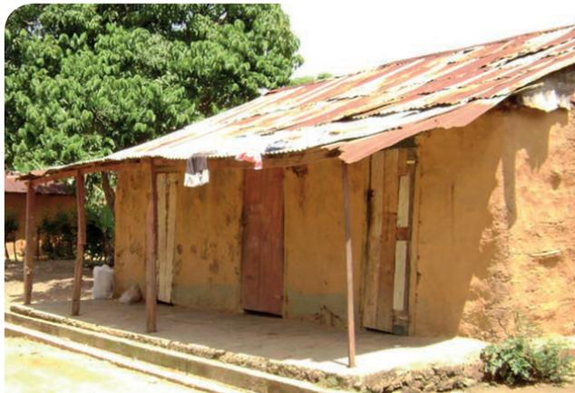
Cubiertas improvisadas con anclajes insuficientes.
