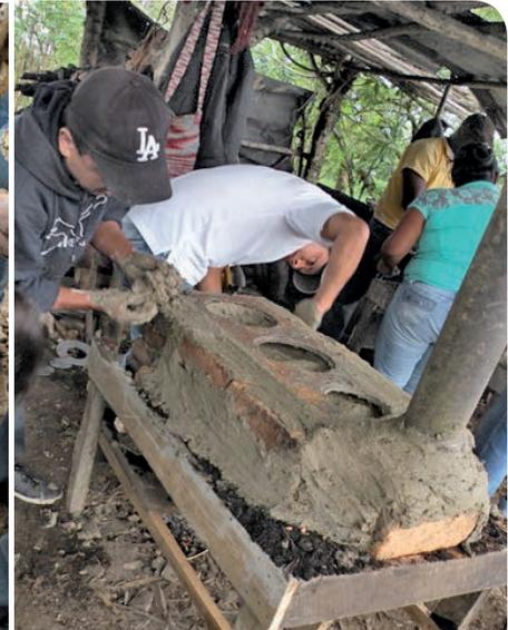
Equipo de investigadores de las Copartes, taller para técnicos. Diseño y construcción de sistemas de estufas eficientes con recursos locales.
